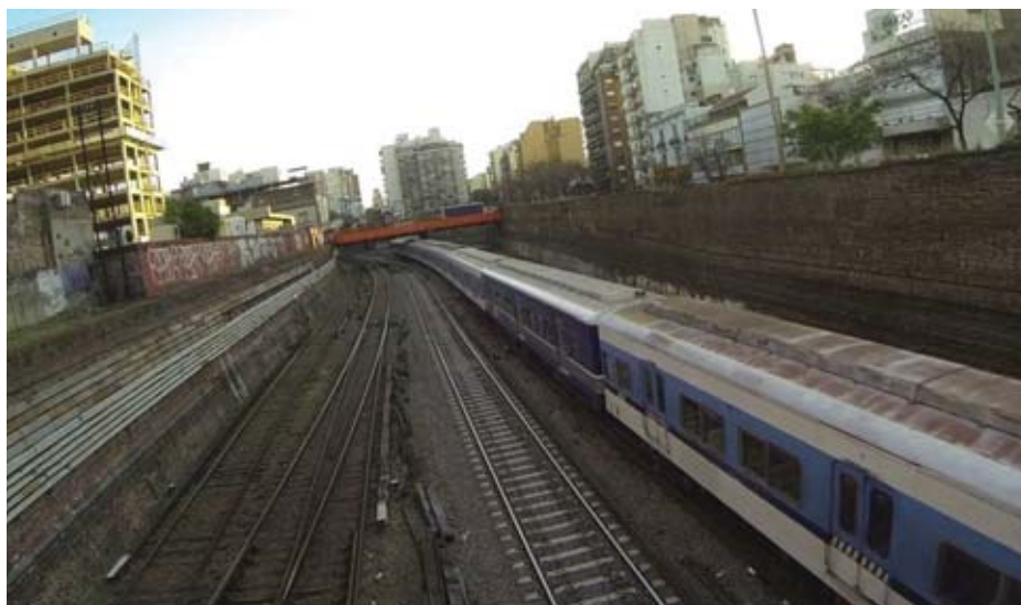
> Soterramiento. La administración Macri prevé recibir un crédito del BNDES para comenzar las obras en la línea Sarmiento
